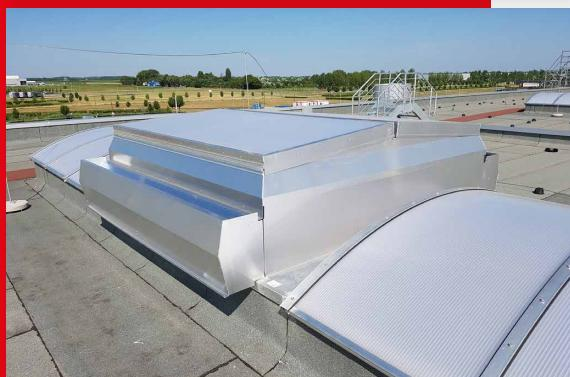
Bei zahlreichen auf das Dach installierten Gravitations-Belüftungsanlagen soll man beim Regen oder Wind den Belüftungsflügel schließen, um die Beschädigung der Anlage oder der darunter gehaltenen Sachwerte, Maschinen zu verhindern.
